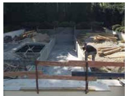
**Der Urzustand: Zum Bau des neuen Beckens wurde der Bestand des Teiches als außenliegende Schalung genutzt. Die Schalung diente dann als Grundlage, um ein neues Becken einzubetonieren. Dann wurde die Betonkonstruktion mit einer Schwimmbadfolie ausgekleidet.**
