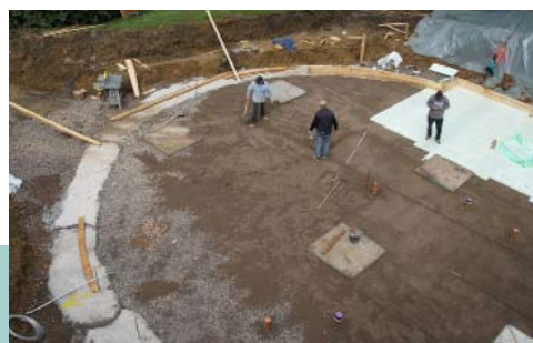
Nach dem Unterfangen des bestehenden Gebäudes starteten die Arbeiten mit dem Gießen der Fundamente für die Außenhaut.
