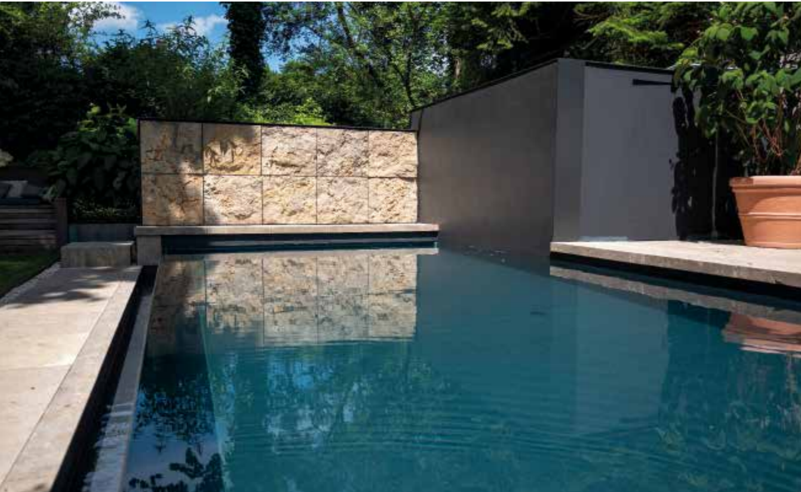
Hinter dem Pool wurde eine Mauer als Blick- und Schallschutzwand zum Nachbargrundstück gesetzt. Direkt ans Becken angeflanscht befindet sich die Technik.
